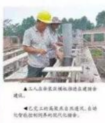
工人正在安装猪舍通风系统,确保猪舍环境舒适。
